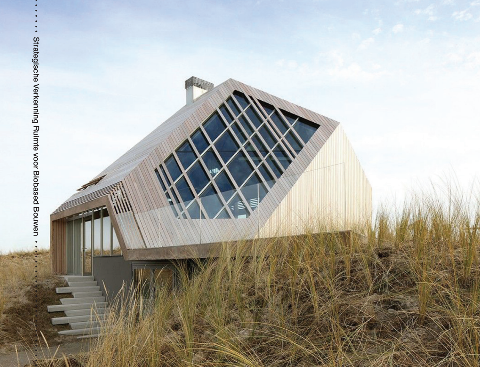
Afb. 10.2 Duinhuis van CLT, Terschelling. Marc Koehler Architects Foto: Filip Dujardin
