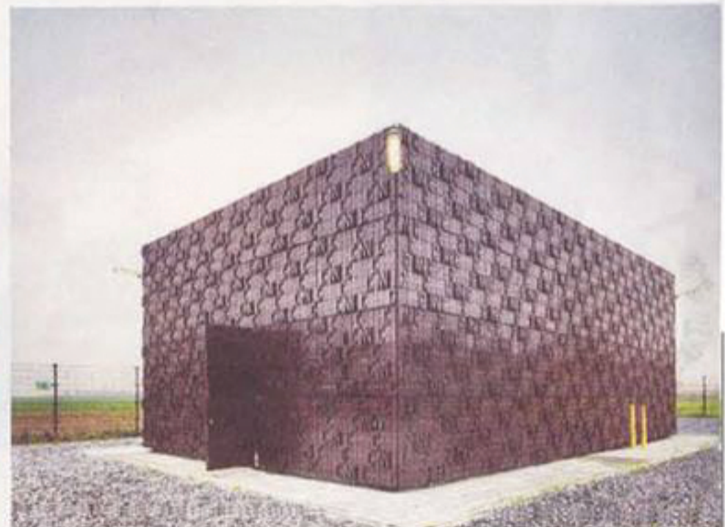
Gasontvangstation Dinteloord van Marco Vermeulen. Foto Ronald Tilleman
