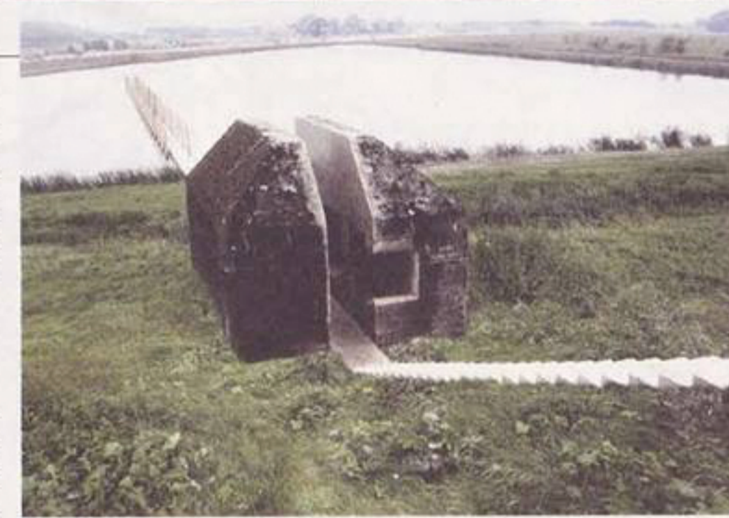
Ronald Rietvelds Bunker 599 voor RAAAF. Foto RAAAF
